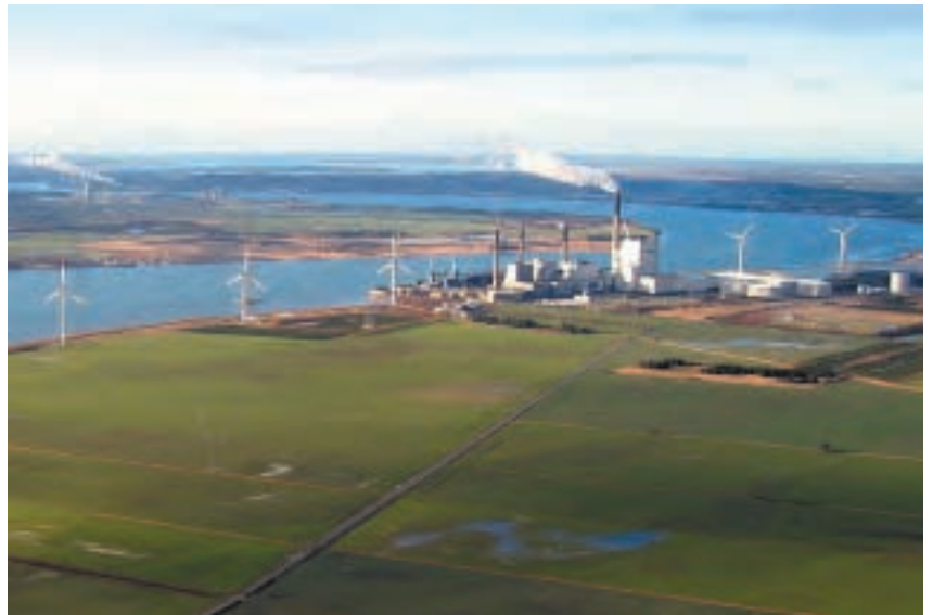
Siguen desarrollándose tecnologías para mejorar el rendimiento medioambiental de las centrales eléctricas alimentadas con carbón: la central eléctrica alimentada con carbón de Nordjyllandsværket, Dinamarca, tiene un nivel de eficacia del 47%. Fotografía cedida por cortesía de Elsam. Fotógrafo: Gert Jensen.
